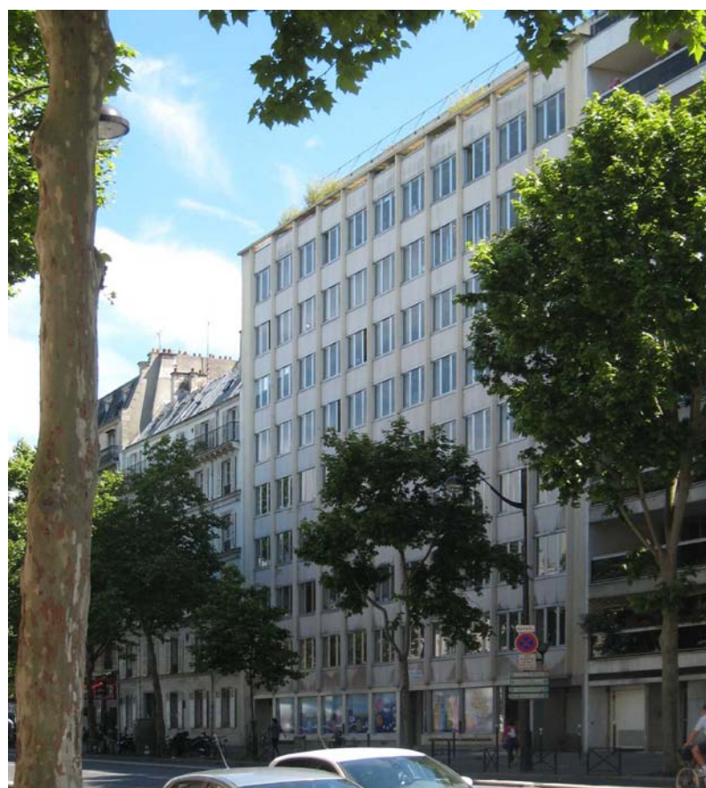
La façade existante
