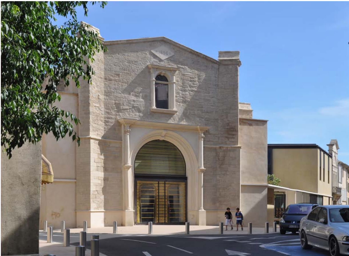
Façade de l'équipement sur l'espace urbain
