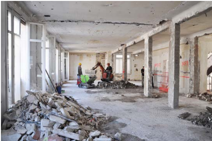
Le chantier de curage complet du bâtiment
