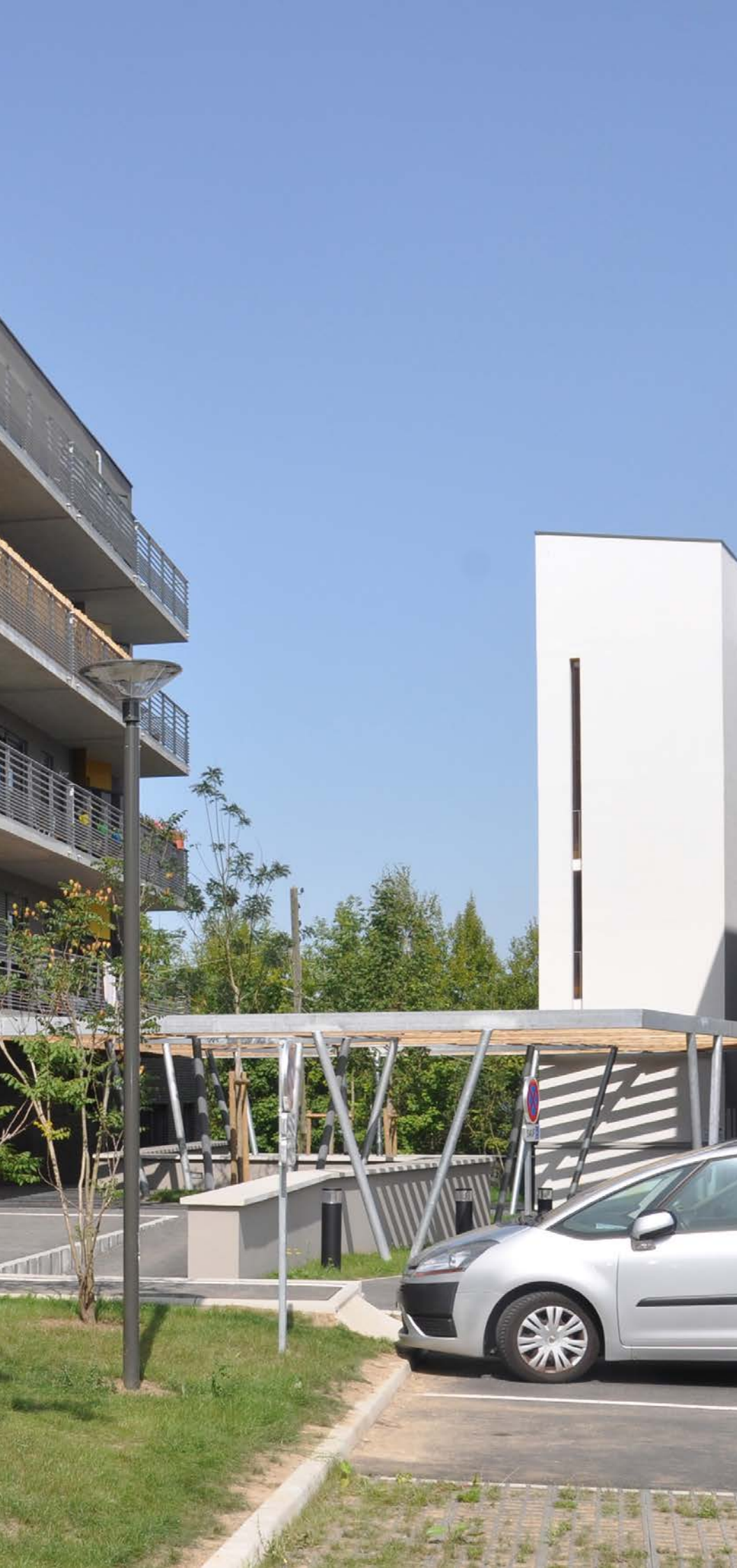
De grands balcons filants et des volets colorés rythment la façade du bâtiment
